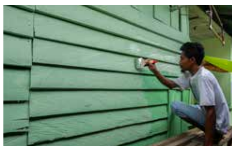
Pengerjaan Renovasi Rumah Veteran
